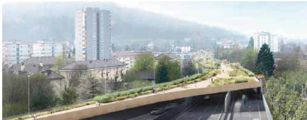
...oder eine komplette Einhausung wie in Zürich Schwammendingen.
