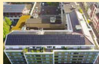
PV-Fassade, Dach und Balkonüberdachung.
